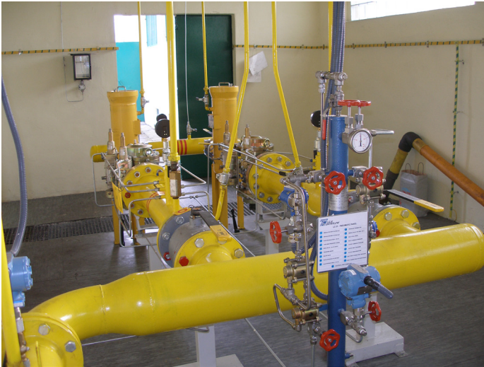
Widok ciągów redukcyjnych oraz jednostki wykonawczej LC-21
