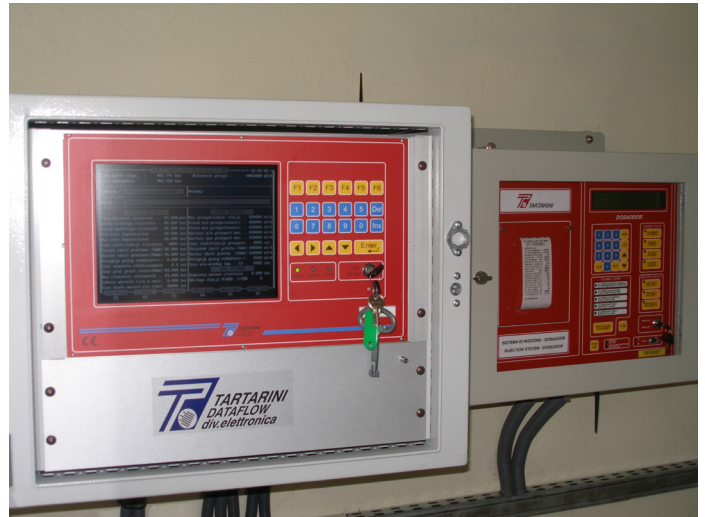
Widok urządzeń redukcyjno-zabezpieczających CRONOS oraz jednostki sterującej LC-21 (z prawej strony - jednostka sterująca nawianialni Dosaodor D)
