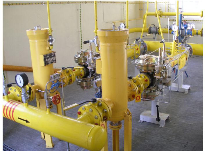
Widok ciągów redukcyjnych oraz jednostki wykonawczej LC-21
